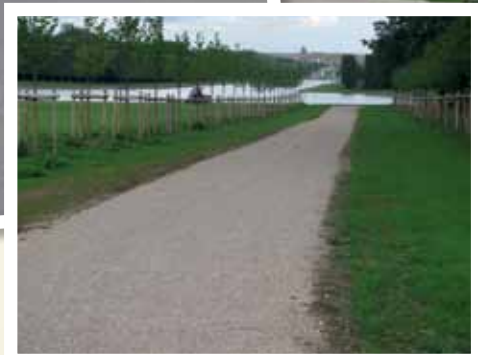
Petit Palais: Fra vejen går man ind på det løse grus. Ved bygning bliver det erstattet af slidlag med Vegecol. Belægningen er udført i 2005.
