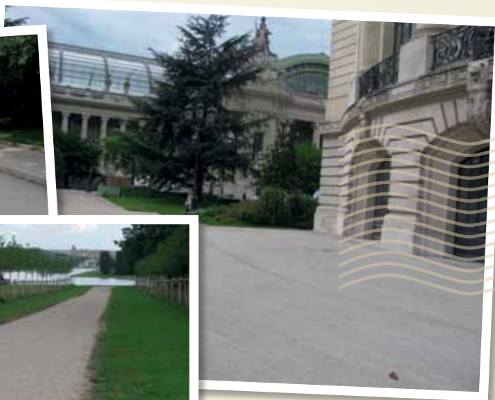
Belægningen ved Versailles Slottet ligner løst grus, men under det tynde lag løse småsten, ligger en fast belægning.
