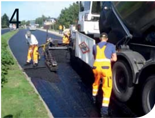
Fremtiden for klimavenlig Warm Mix Asphalt i Danmark.
