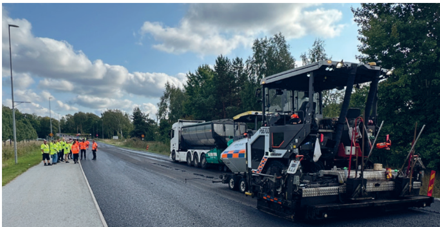
Der ventes på, at asfaldtumlægningen går i gang.
