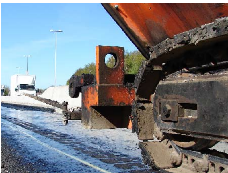
Klar til at udlægge asfalt.
