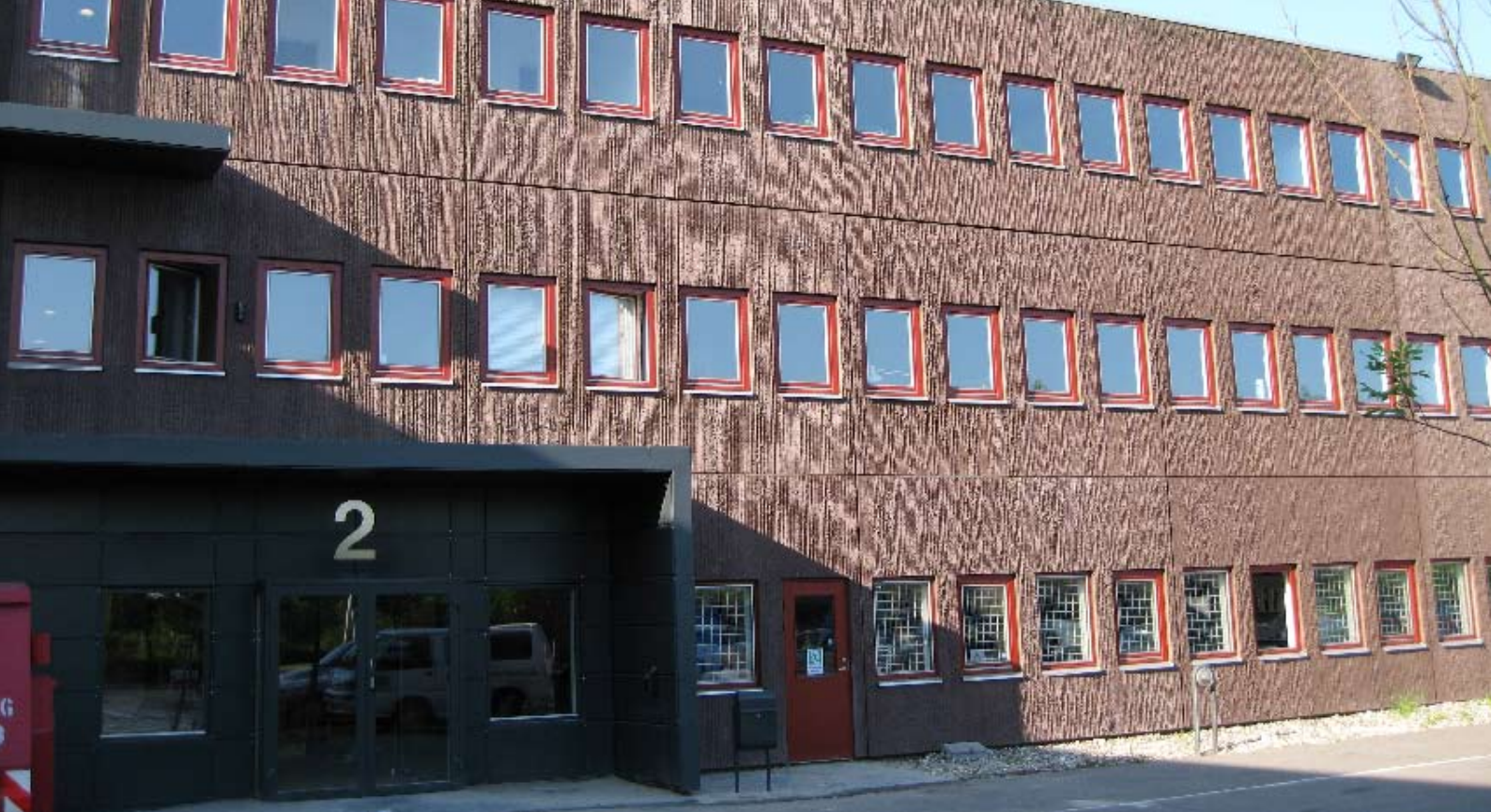
Asfaltindustrien bor pr. april på 2. sal af denne bygning på Lautrupvang 2 i Ballerup. Asfaltindustriens nye Hus har en optimal trafikal beliggenhed tæt på Ring 4 og motorvejsforgreningen til Ballerup. Endvidere er der ikke langt til nærmeste busstoppested og S-togsstation.
