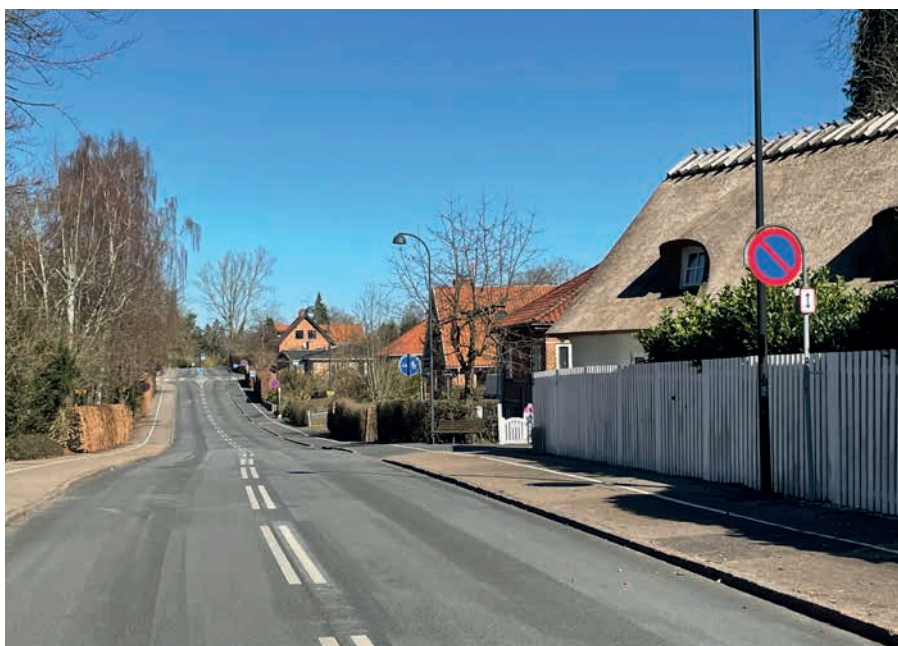
Forårets komme er et tegn til at sætte asfaltarbejde i gang.
