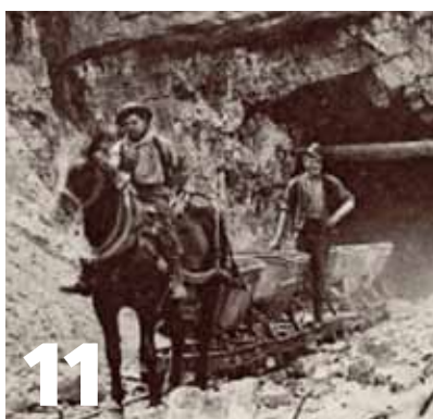
På jagt efter naturligt asfalt i Schweiz.
