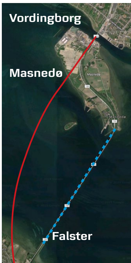
Den nye Storstrømsbro set fra oven, med den nuværende linjeføring vist punkteret
