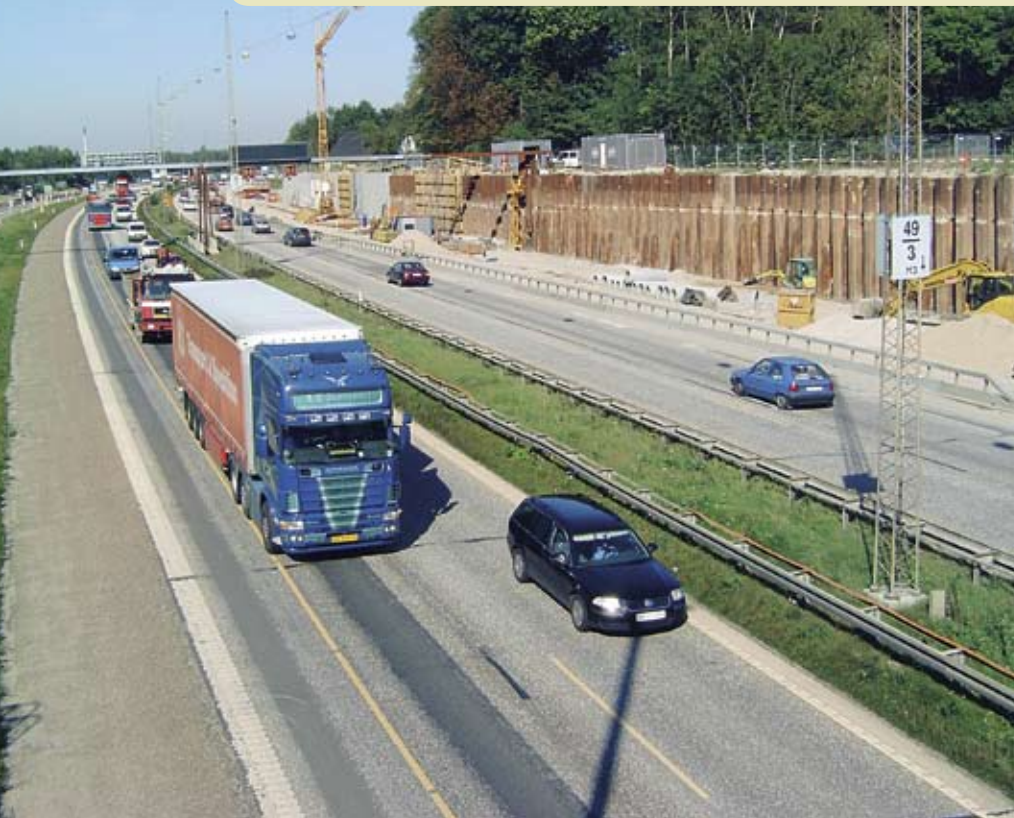
Sideudvidelserne på Motorring 3 må mange steder foretages ved at etablere støttmure. Her er man i gang på strækningen lige nord for Roskildevej.
