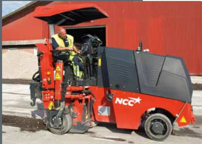
Fræserfører Allan Jensen på sin nye BOMAG-asfaltfræser på arbejde i Hobro.
