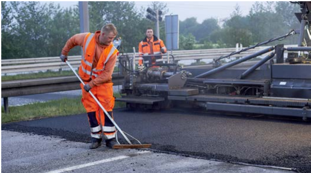
Udlægning af slidlag
