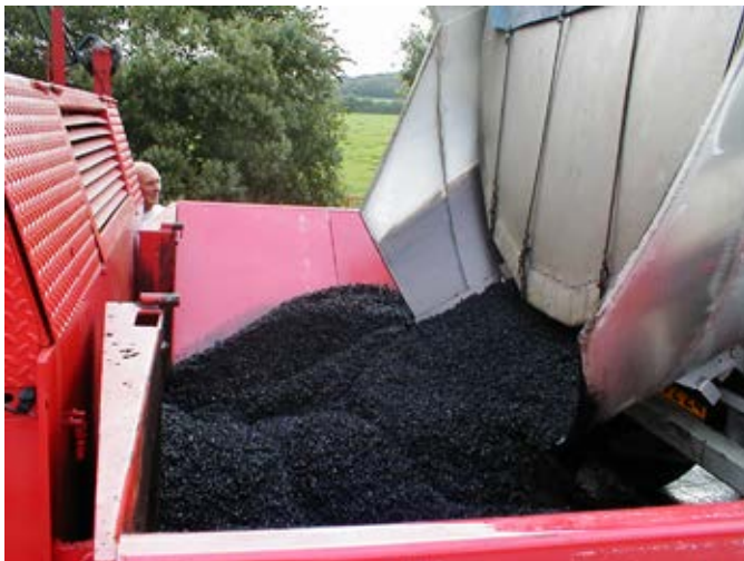
Aflæsning af asfalt i udlægger
