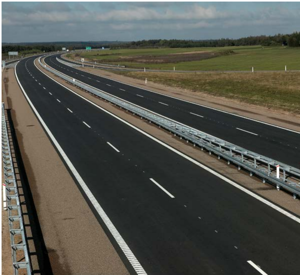
Nyanlagt motorvej på strækningen mellem Høgild og Brande
