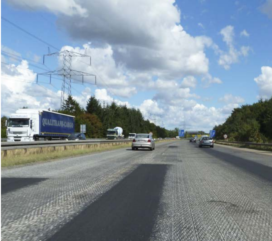
Affræset belægning, klar til nyt slidlag
