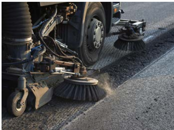
Fejning af fræset overflade
