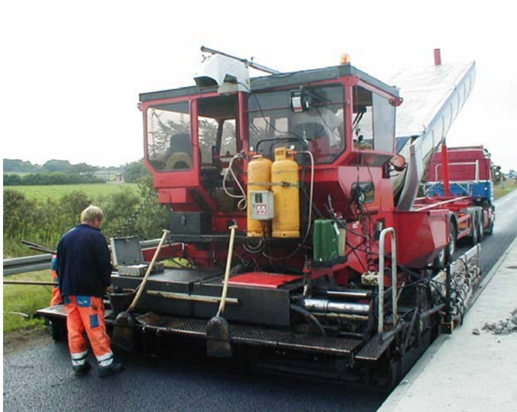
Læsning af asfalt fra rundbundet bil til udlægger
