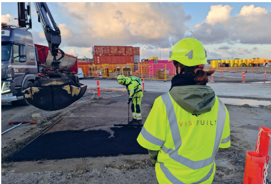
Udlægning til test af asfalt med Visibuilt ved Femern-forbindelsen.
