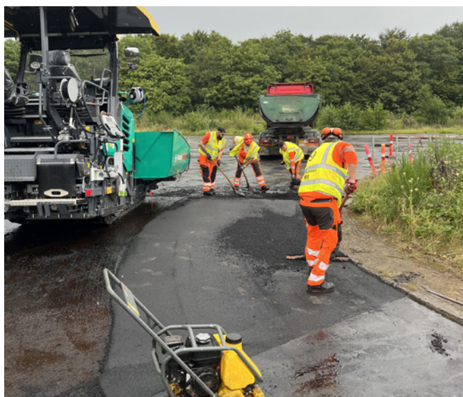
Et hold lærlinge til den praktiske prøve i samarbejde om at udlægge asfalt i et stykke af en rundkørsel.
